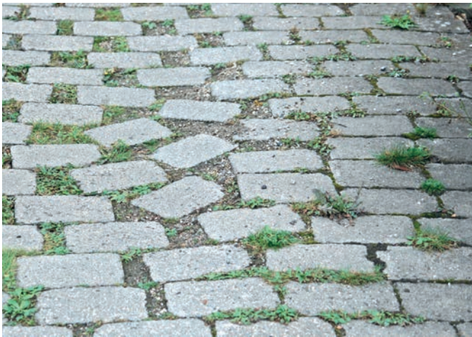
Beispiel Entsiegelung durch Fugenabstände
